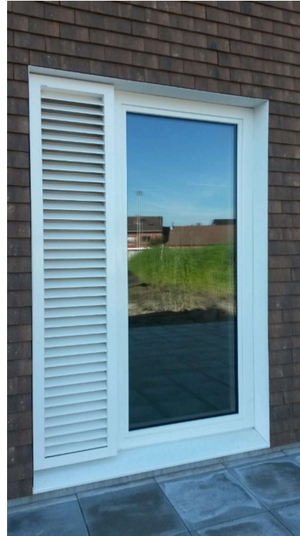
Opengaand raamdeel met inbraakwerend rooster
