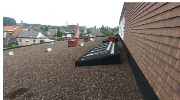
Dakaanzicht met dakopstanden voor luchtgroepen
