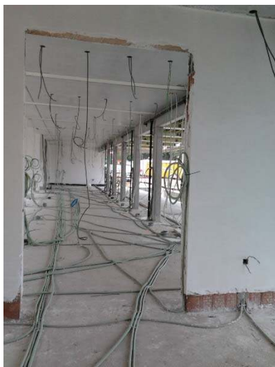
Inbouwvoorzieningen plafond (geen verlaagd plafond)
